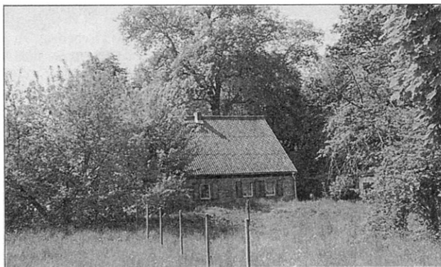
Ehem. Fischerhaus von der B 246 aus gesehen
